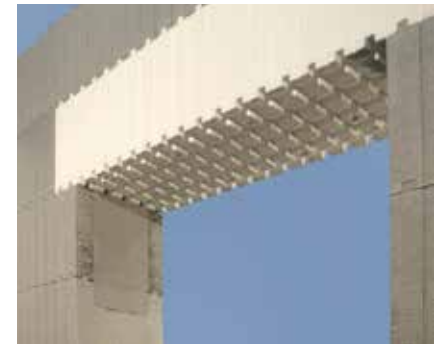
Dintel. El componente de dintel en la sección tiene forma de la letra U.
