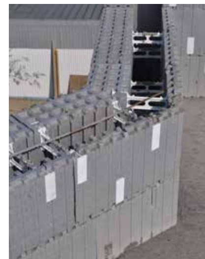
Uso de los componentes de bisagra para formar equinas con cualquier ángulo.
