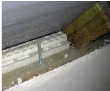
El componente MP permite colocar la armadura de la corona dentro del eje de la pared y soportar el piso.
