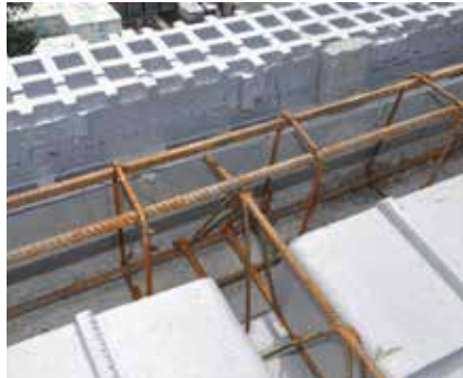
El componente MP permite colocar la armadura de la corona dentro del eje de la pared y soportar el piso.
