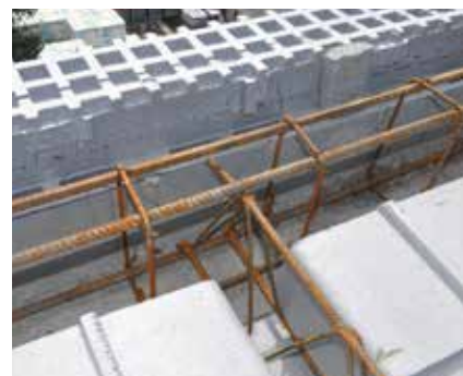
O componente MP permite colocar a armadura de aço na viga superior, dentro do eixo da parede para suportar o piso.
