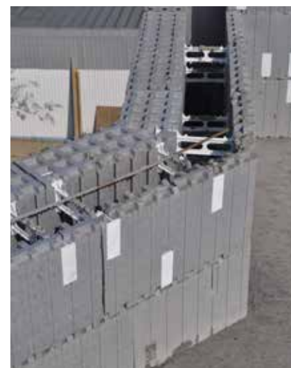
Uso do componentes tipo dobradiça para formar cantos com qualquer ângulo.
