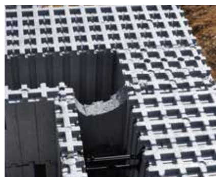
Usunięcie fragmentu elementu zapewnia ciągłość wypełnienia betonem.
