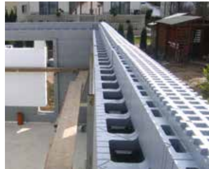
O componente viga superior MP, tem uma capa exterior de isolamento idêntica a toda a parede.
