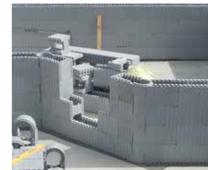
Uso do componentes tipo dobradiça para formar cantos com qualquer ângulo.
