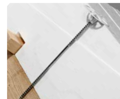
Parafuso para montar placas de teto Izodom.
