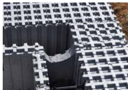
A eliminação de um fragmento do componente garantirá a continuidade do preenchimento com o concreto.
