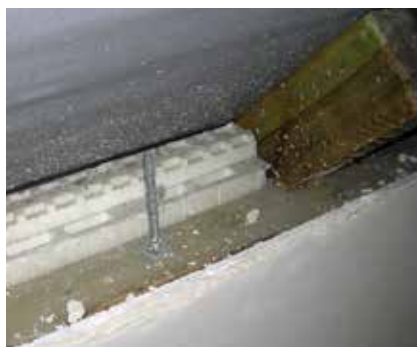
MP elements ļauj ievietot sasaistes armatūru sienas asīs un pārsedzes atbalstos.
