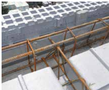
MP elements ļauj ievietot sasaistes armatūru sienas asīs un pārsedzes atbalstos.
