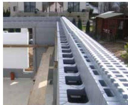
Sasaistes elementam MP ir ārējais izolācijas slānis, tāds pats, kā visa siena.
