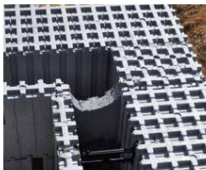
Elementa fragmenta aizvākšana, nodrošina vienlaidus betona pildījumu.
