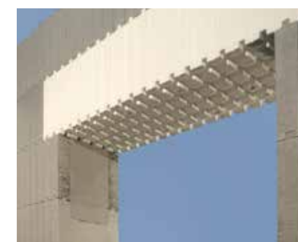
Savienojums. Savienojuma elements šķēsgriezumā atgādina burtu U.
