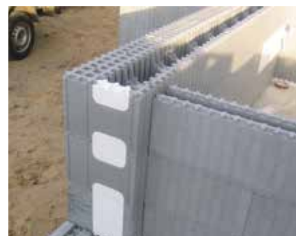
Izveidojot durvju un sienu atveres un noslēdzot sienas – atveres veidņos noslēdzam ar elementiem OH, OB un OC.
