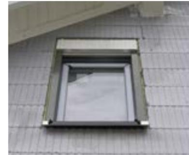
Wenn es um die Energieeffizienz gehen soll, befestigt man die Rahmen in der Ebene der äußeren Isolationsschicht und verwendet dabei die sog. warme Montage entsprechend den Empfehlungen des Herstellers der Tischlerelemente.
