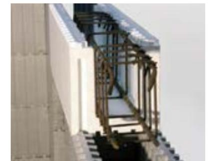
Im Sturzelement ML ist das Verlegen der Bewehrung einfach.
