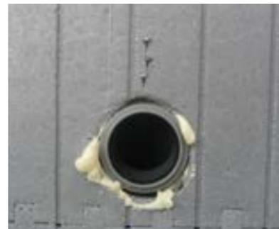
Die Wasser- und Kanalisationsanlage kann man auch in den Wandschlitz verlegen, die in der Styropor-Innenwand mit einer Dicke von 5 cm gefertigt sind.
