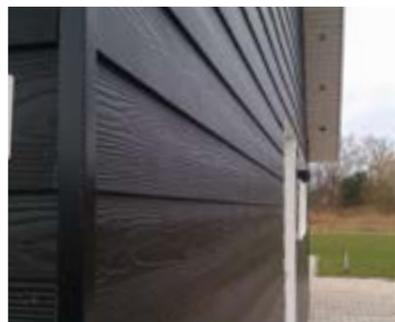
In Skandinavien sind die Holzfassaden sehr populär, die auf Gestellen befestigt werden. Diese wiederum werden mit Spreizdübeln in der Isolierschicht montiert.
