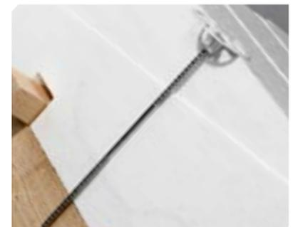
Spreizdübel für die Montage der Dachplatten von Izodom.
