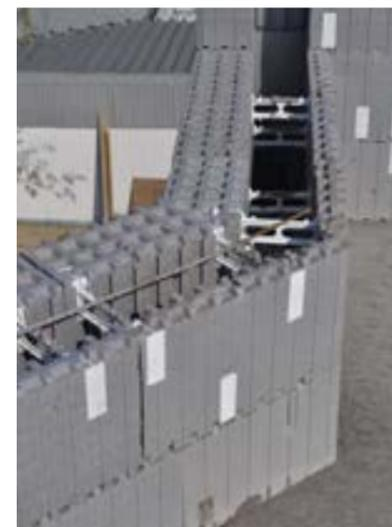
Alle Eckstückelemente werden in zwei Varianten produziert – „links“ und „rechts“ – ein Teil des Elements ist länger, wodurch ihre Verbindung mit den Wandelementen als „Überlappung“ möglich ist.
