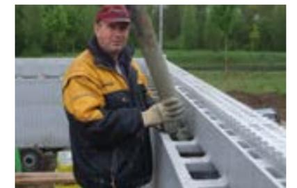
Verlegt man den Beton mit einer Pumpe und einer Zuführungsgeschwindigkeit von 6 – 9 m<sup>3</sup> kann man 40 bis 70 m<sup>2</sup> Wand in kaum 1 Stunde ausfüllen!
