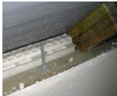
Das Element MP eignet sich ausgezeichnet für die Isolierung der Mauerlatte. Den Kniestock kann man mit diesem Element beenden und die Mauerlatte in der Achse der Wand an den Betonkern befestigen. Die Isolierung des Formteiles MP lässt sich sehr einfach mit der Isolierung des Daches verbinden.
