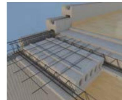
Die vorgefertigten und durch die Firma bereitgestellten Bewehrungsbalken verlegt man zwischen die Deckenelemente von Izodom. In Abhängigkeit von der Breite des Raumes wählt die Firma Izodom die Balken mit der entsprechenden Länge aus, sogar bis zu 7,8 m. Auf den Elementen verlegt man die Bewehrung der Deckenplatte. Die Bewehrung der Rippen – Balken stützt sich auf die tragenden Wände.
