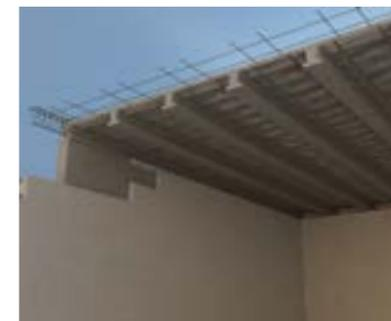
Die Deckenplatte aus Stahlbeton mit einer Dicke von 6 cm wird auf horizontalen Balken – Rippen gestützt, die jeweils nach 75 cm verlegt werden. Alle Konstruktionselemente sind dauerhaft in den tragenden Wänden eingesetzt. Auf der obigen Abbildung wurden die Styroporelemente unter der Decke beseitigt, um die konstruktiven Betonelemente besser exponieren zu können.
