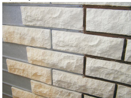
Zamontowane płytki klinkierowe na płycie dociepleniowej
