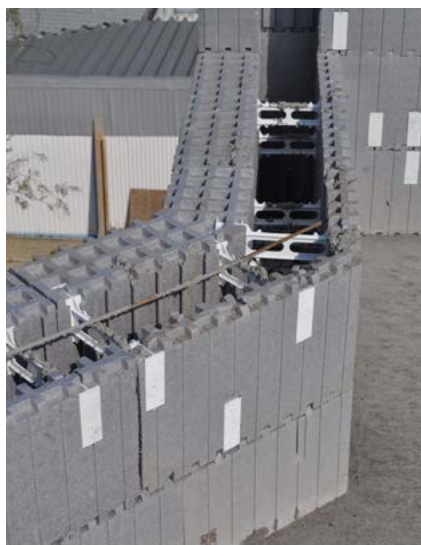
Gebruik van scharnierelementen voor de uitvoering van hoeken in om het even welke graad
