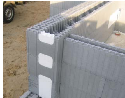
De openingen in de muurelementen kunnen indien nodig worden opgevuld met de OH, OB en OC elementen.
