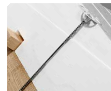
Cheville expansible pour montage des dalles de toiture Izodom.
