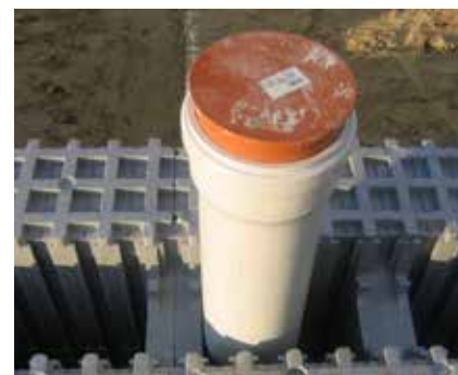
L'élément MP permet la pose d'armature du couronnement dans l'axe du mur et l'appui du mur.
