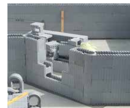
Utilisation d'éléments à charnière pour la formation des angles de mur sous angle quelconque.
