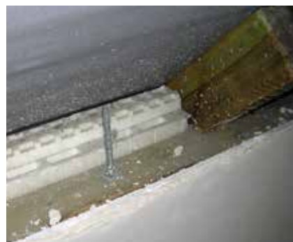
L'élément MP permet la pose d'armature du couronnement dans l'axe du mur et l'appui du mur.
