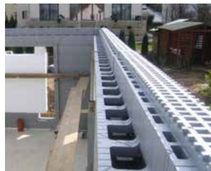
L'élément de couronnement MP possède une couche interne d'isolation, identique à celle du mur entier.
