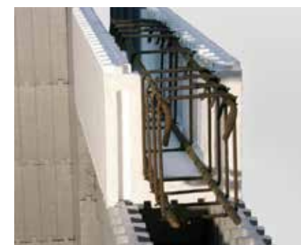
Dans l'élément de linteau ML la pose d'armature est facile.
