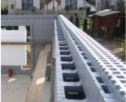
El componente coronario MP tiene una capa exterior del aislamiento idéntica a toda la pared.
