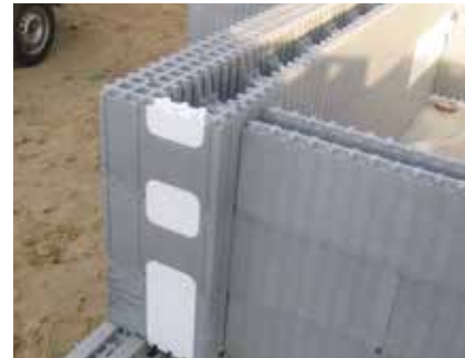
Construyendo vanos y terminaciones embotadas de las paredes, cerramos los huecos del encofrado con los componentes OH, OB i OC.
